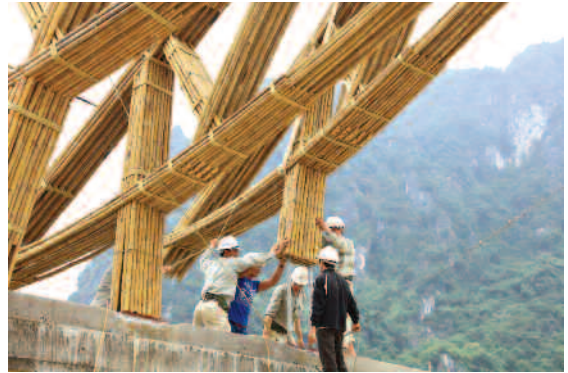
Tre làm các kết cấu xây dựng.
