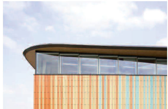
Lớp vỏ tiết kiệm năng lượng, chiến lược thông gió thụ động và mái che nắng giúp giảm mức tiêu thụ năng lượng.
