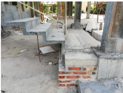
Hình B.16 – Liên kết giữa bản thang với dầm
