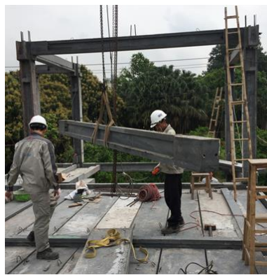
Hình B.12 – Lắp đặt cầu kiện dầm
