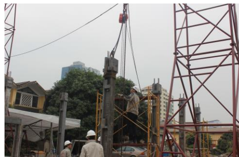
Hình B.8 – Lắp đặt cấu kiện cột
