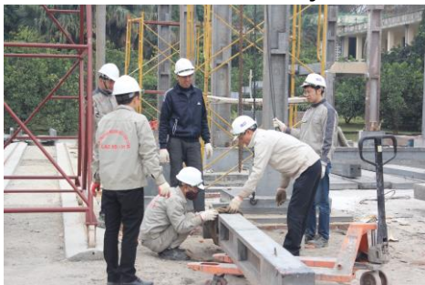
Hình B.7 – Cầu cấu kiện cột
