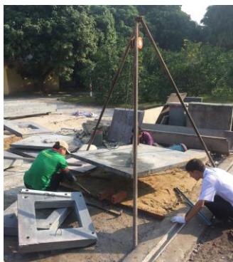
Hình B.1 – Lắp đặt bản đáy móng
