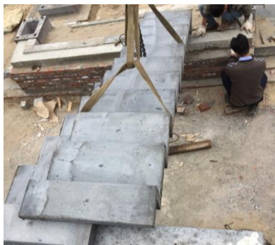
Hình B.14 – Lắp đặt các bản thang
