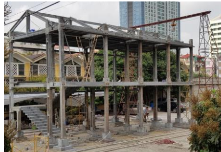
Hình B.14 – Nhà bê tông lắp ghép
