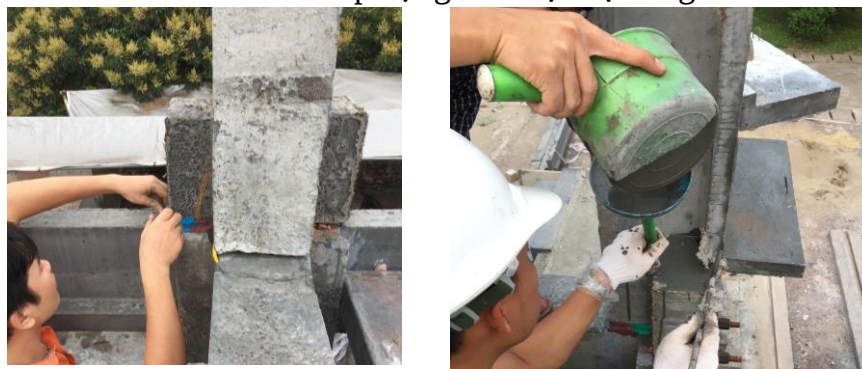
Hình B.11 – Thi công chèn kín mối nối liên kết cột – dầm
