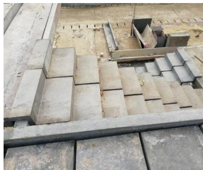
Hình B.14 – Lắp đặt các bản thang
