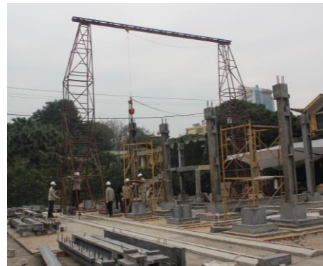
Hình B.4 – Kết cấu móng sau lắp đặt
