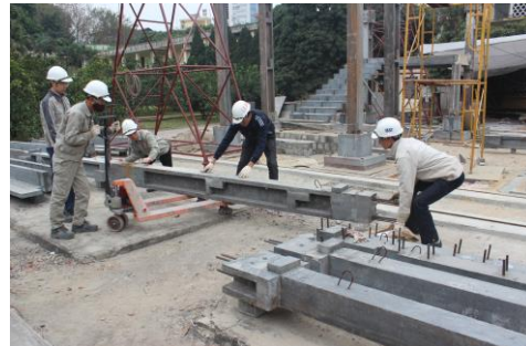
Hình B.6 - Cấu kiện cột đến vị trí lắp đặt
