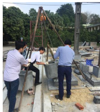
Hình B.2 – Lắp đặt cổ móng
