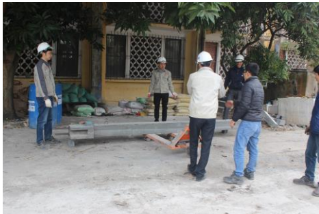
Hình B.5 – Vận chuyển cấu kiện cột
