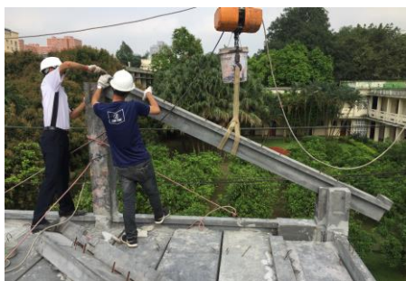
Hình B.13 – Lắp đặt dầm mái
