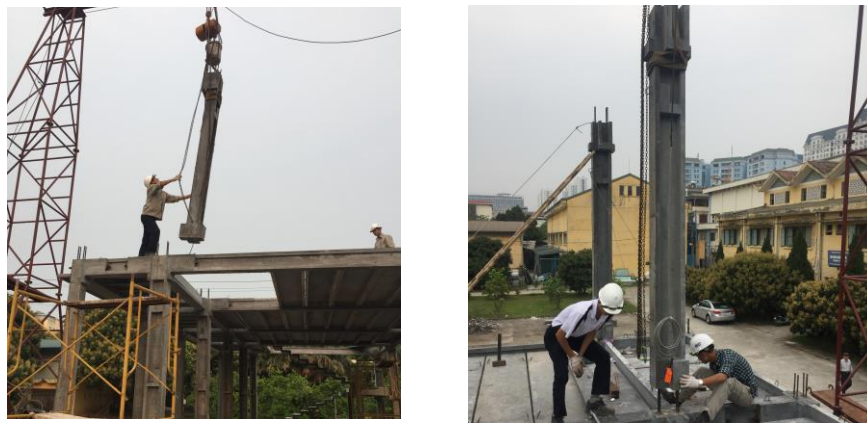
Hình B.10 – Lắp dựng cầu kiện cột tầng 2
