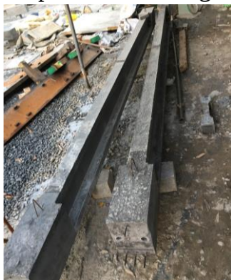
Hình B.12 – Lắp đặt cầu kiện dầm
