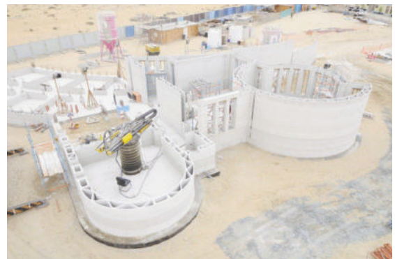
Nhà in 3D lớn nhất thế giới tại Dubai, UAE
