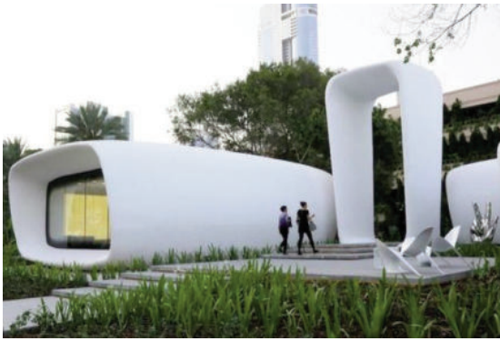
Tòa nhà văn phòng Future (UAE) được xây bằng công nghệ in 3D
