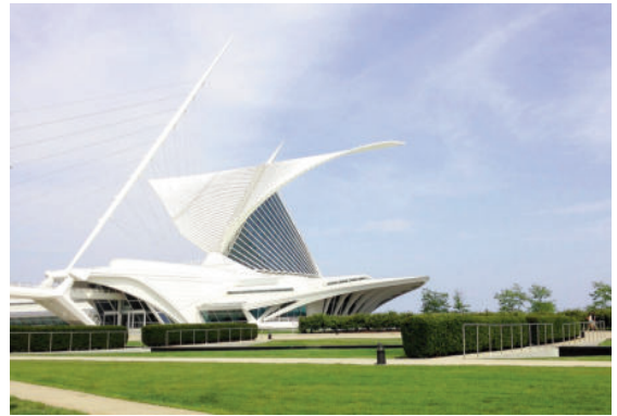
Quadracci Pavilion, Bảo tàng Nghệ thuật Milwaukee (Mỹ) với những cánh lớn trên mái có thể tự động xòe /cụp tùy theo cường độ ánh sáng tự nhiên
