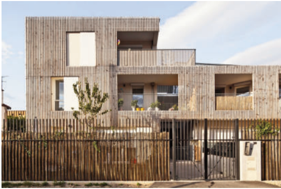
Khu nhà ở xã hội tại Nantes (Pháp) do MaOarchitectes Tectone thiết kế
