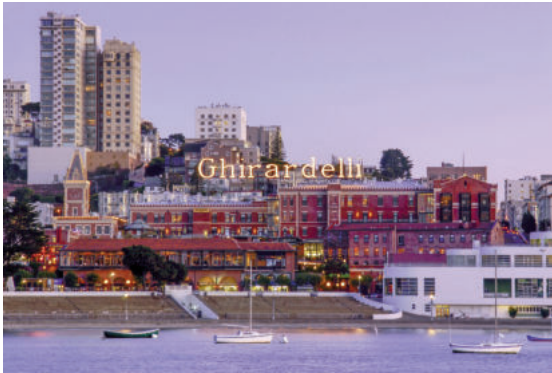
Nhà máy kẹo chocolate Ghirardelli (San Francisco, Mỹ) được chuyển đổi chức năng thành tổ hợp thương mại - giải trí, kiến trúc mặt tiền vẫn được bảo tồn nguyên vẹn
