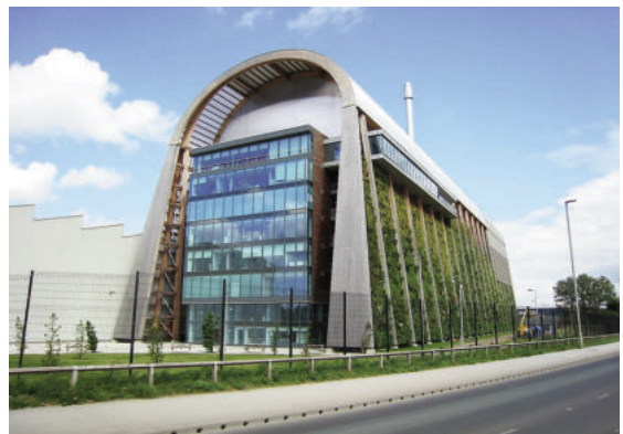
Nhà máy đốt rác tại Leeds (Vương quốc Anh) có bề ngoài giống nhà kính lớn
