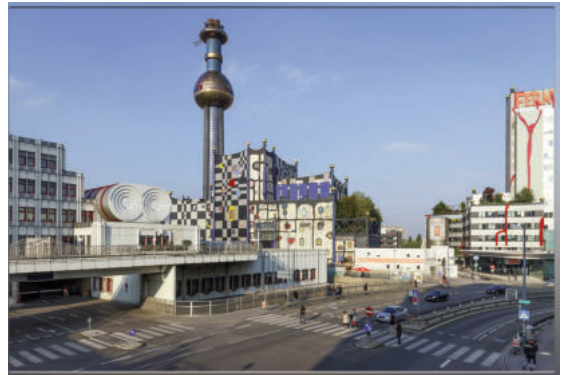
Nhà máy đốt rác Spittelau tại Vienna (Áo)
