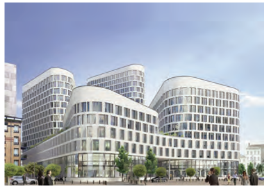
Tổ hợp đa năng Quatuor gần ga đường sắt Bắc Brussels (Bỉ) được đánh giá Xuất sắc theo hệ thống BREEAM
