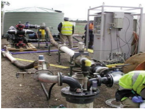
Khôi phục tầng chứa nước ngầm bằng bơm nước bề mặt xuống bãi giếng Werribee- Australia
