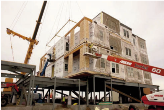
Xây dựng module tại Nga
